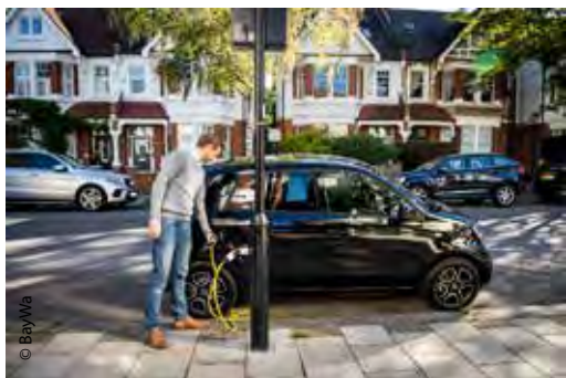
Strom tanken am Laternenmast.
